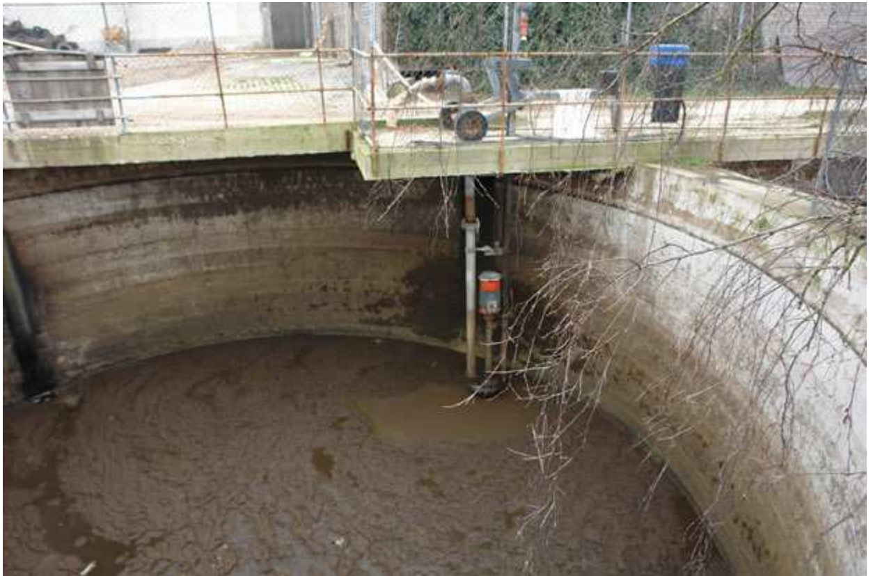
Sammelbecken für Gülle (tierische Fäkalien mit Wasser): Aus Gülle kann Biogas erzeugt werden
