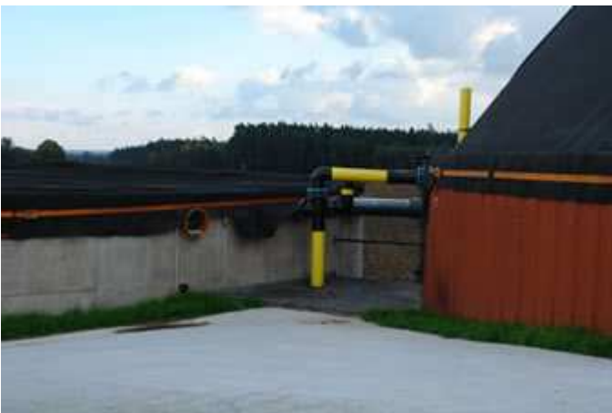
Gasverbindungsleitungen
