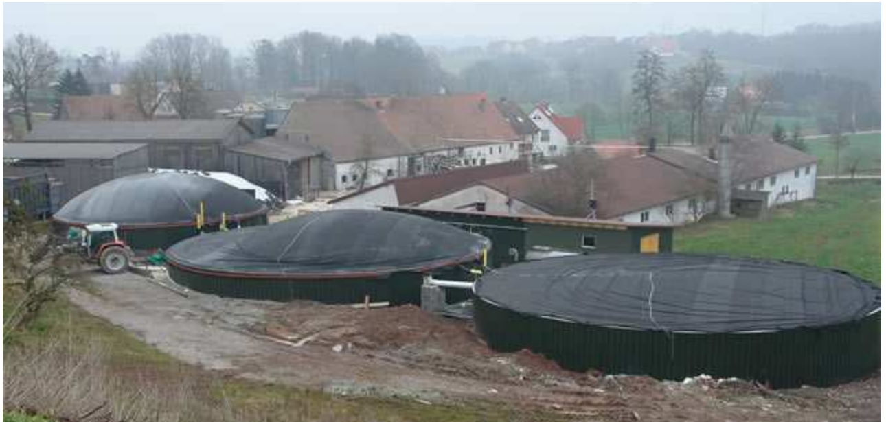
Biogasanlage mit drei Gärbehältern (Fermentern)
