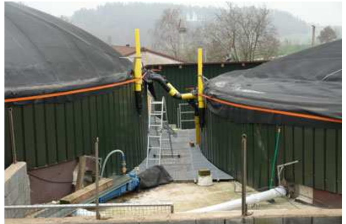
Gasverbindungsleitungen
