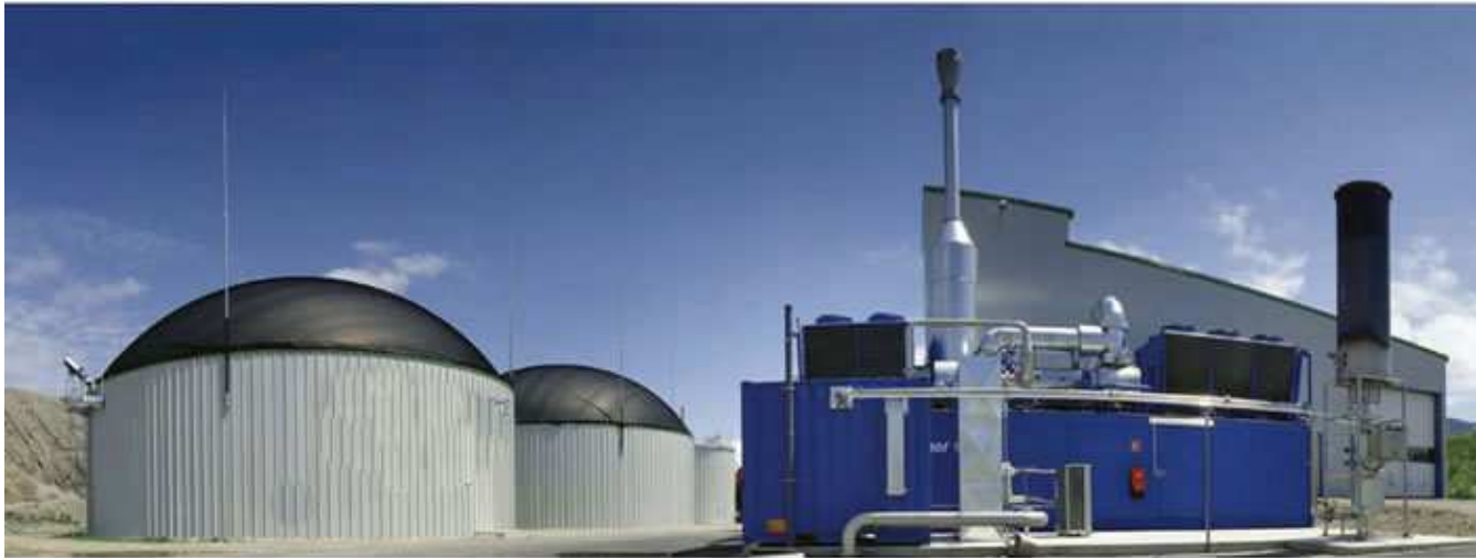
Dreistufige Biogasanlage
