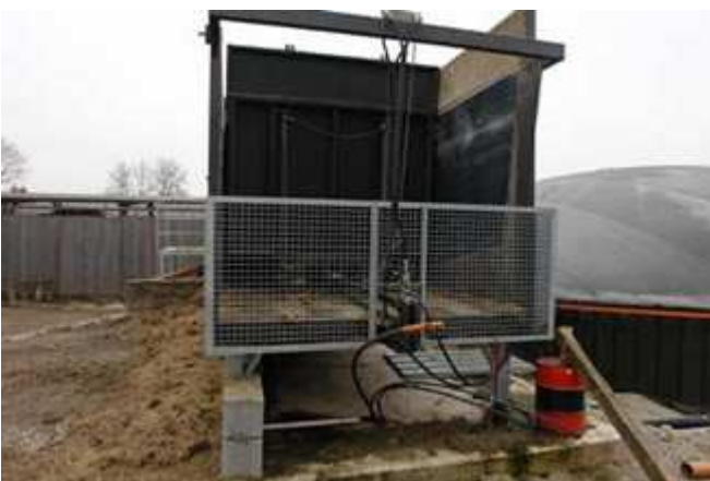
Zufuhreinrichtung zur Befüllung des Fermaters
